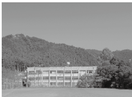
▲解体予定の旧 本山中学校
