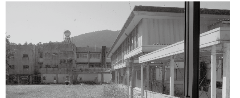
▲旧 本山中学校の北側の状況
