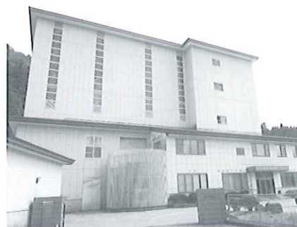
▲平成29年4月から大規模改修が予定されている清掃センター
