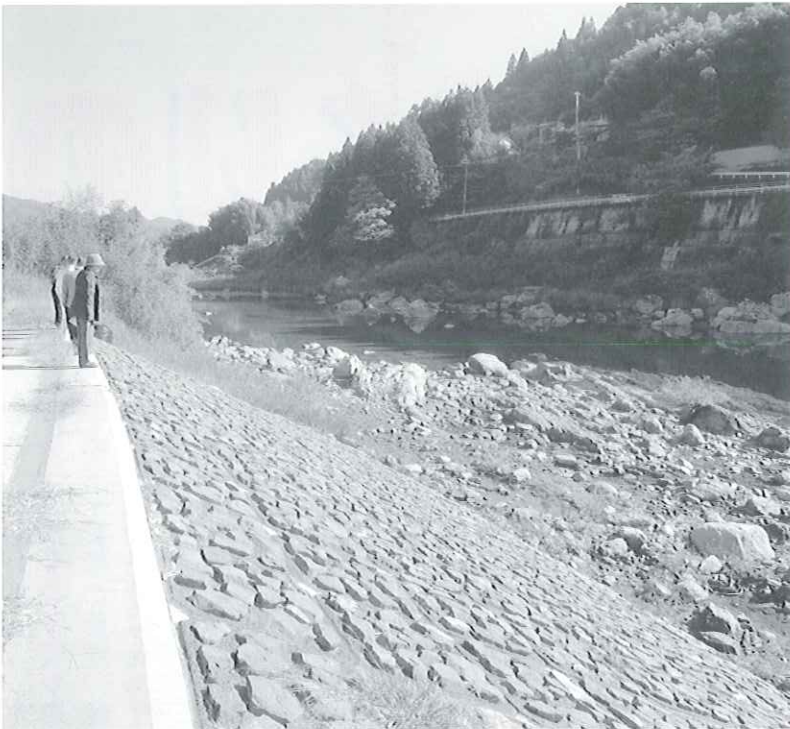
▲吉野川カヌー競技場下流の護岸工事現場
