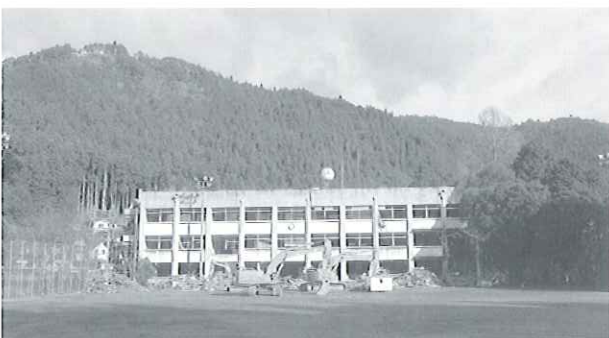
▲解体作業が始まった本山中学校跡地
