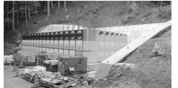
▲配水池施設工事（四区）
