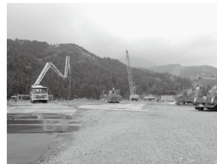
▲工事が始まった福祉ゾーン施設
