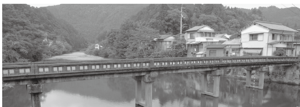
▲新歩道橋架橋後撤去される町道吉野橋
