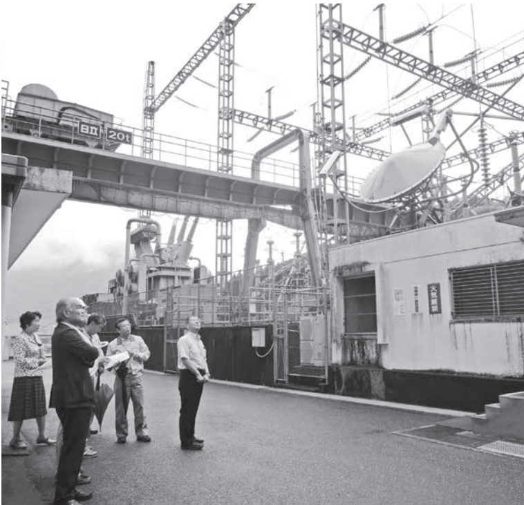
▲早明浦発電所内部見学し説明を受けた
