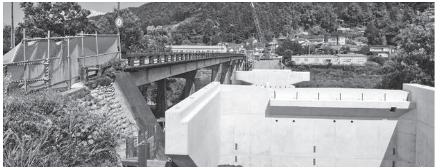
▲土佐本山橋工事
