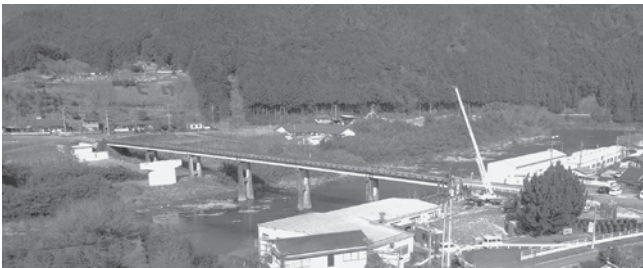
▲工事が進む土佐本山橋
