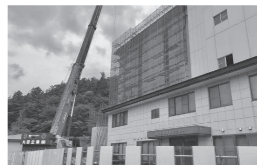
▲改修中の清掃センター
