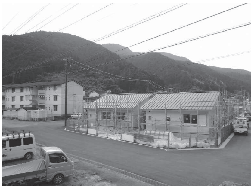
▲工事中の更新住宅
