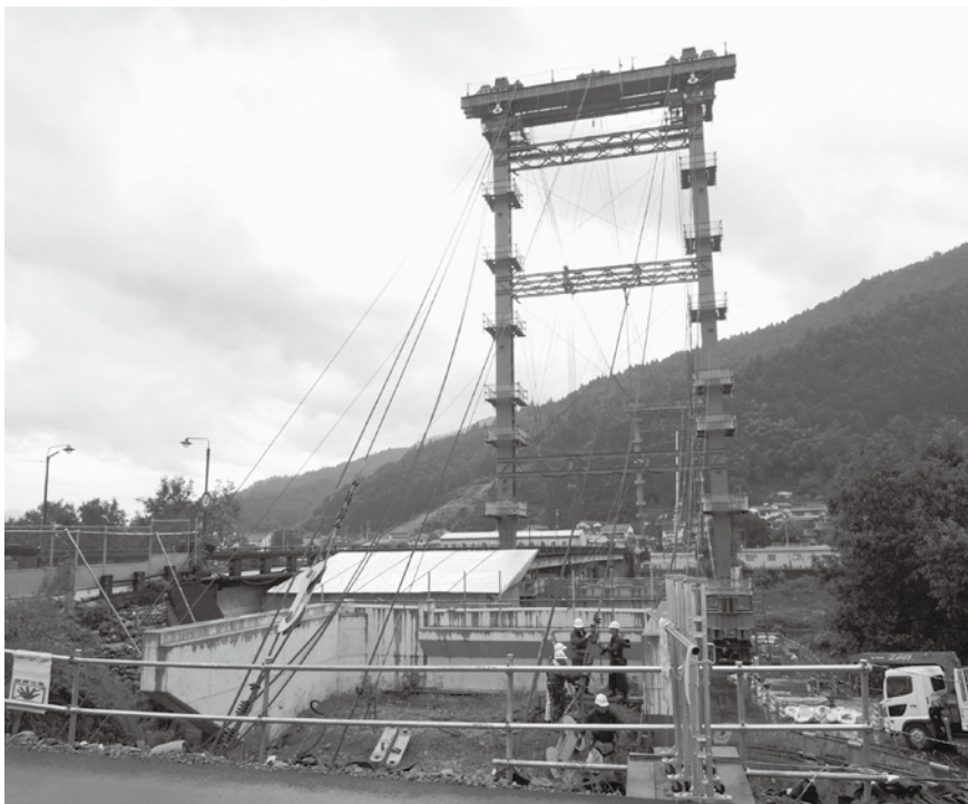
▲建設中の土佐本山橋
