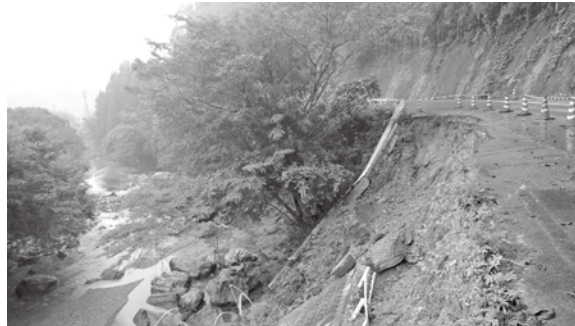
▲7月豪雨による被災状況
