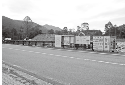
▲工事が進むアウトドア施設
