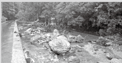
▲急ぐ国の直轄事業による災害復旧
