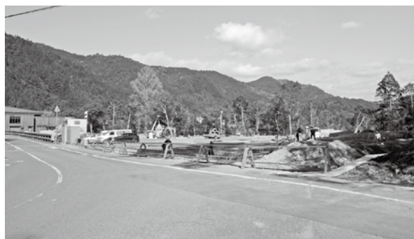
▲工事が進むアウトドア施設
