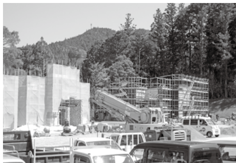
▲工事が進むアウトドア施設
