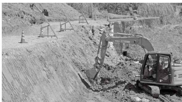
▲復旧の進む町道高角古田線
