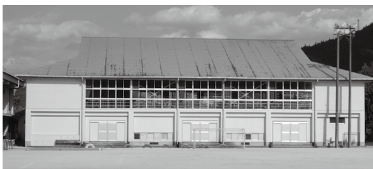
▲屋根が劣化した本山小学校体育館
