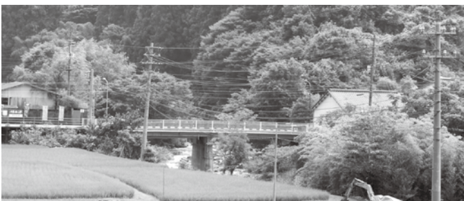
▲本山橋（井窪）の着工は
