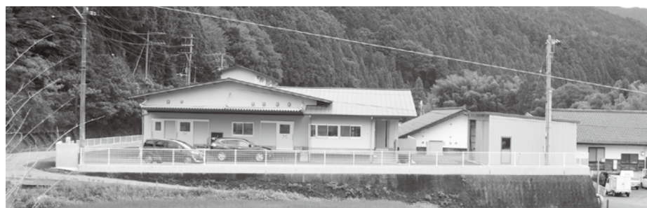
▲移転新築の土佐本山学校給食センター
