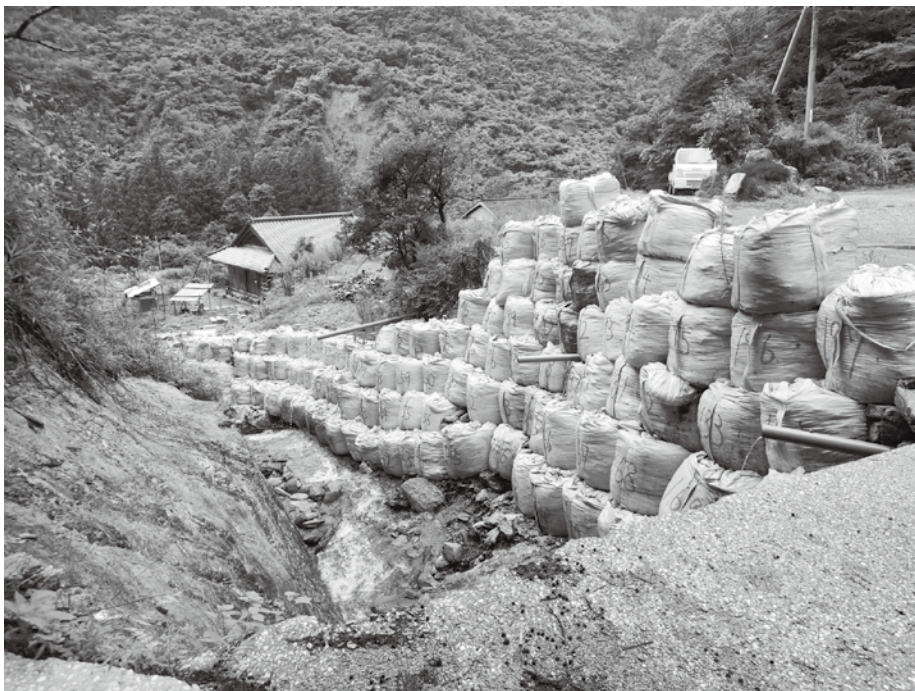
▲砂防工事が進むコナンナ口谷川
