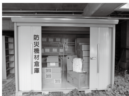
▲緊急時の備えも万全 防災機材倉庫
