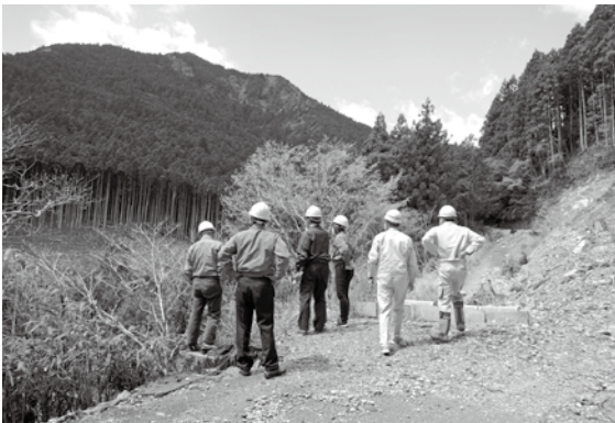
▲林道蛇ヶ野線崩落 現場視察
