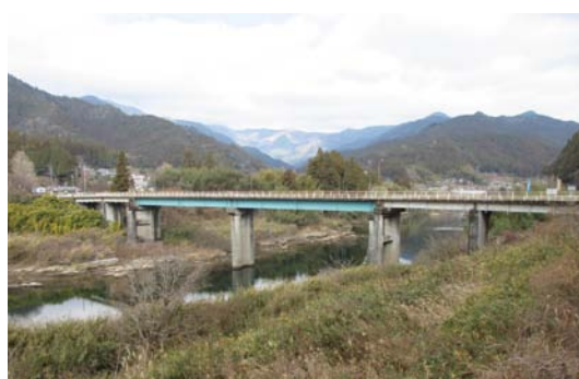
▲塗り替え工事をする本山東大橋
