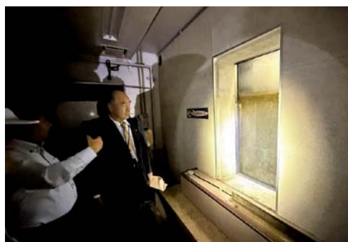
▲遡上が確認できた暗渠箇所
