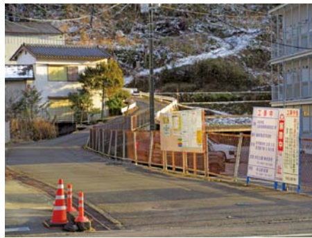
▲旧給食センター横の町道新道連絡線
