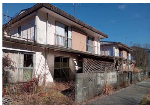
▲取壊しが急がれる改良住宅
