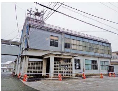
▲解体される旧庁舎
