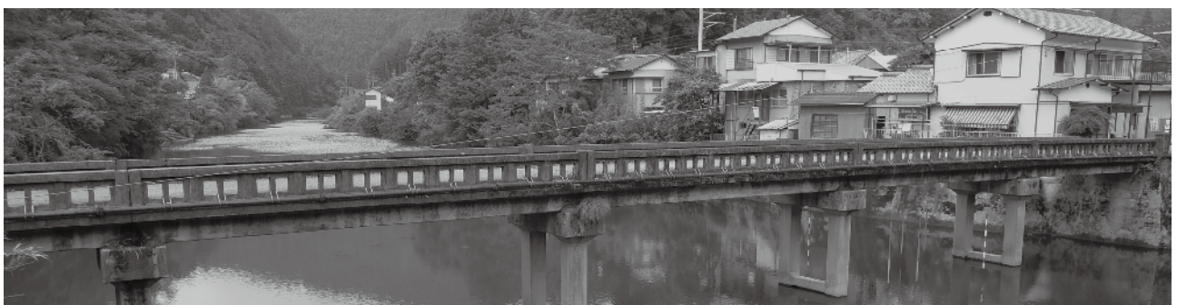
▲撤去予定の町道吉野橋
