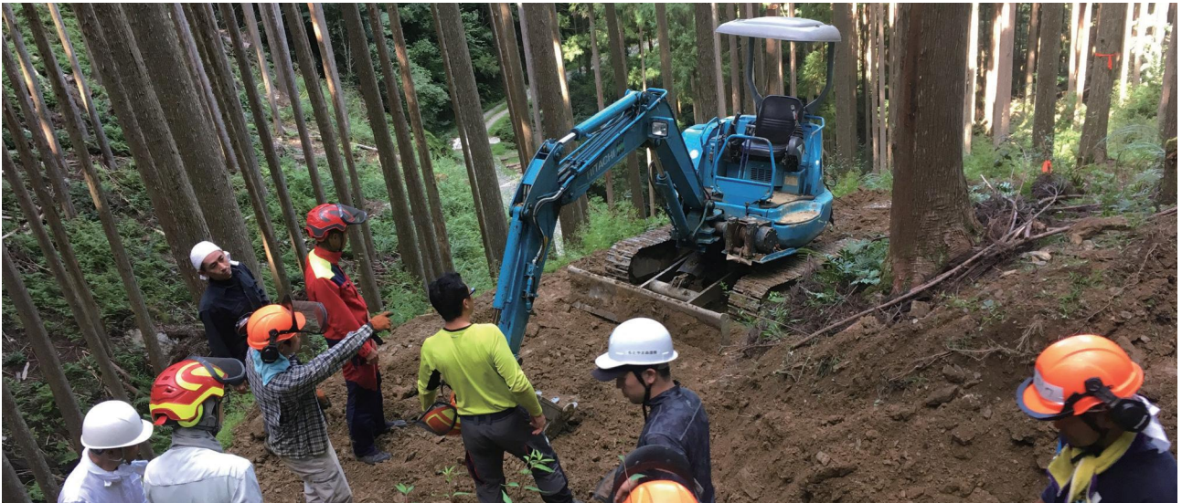
バックホーによる作業道作設研修の様子
